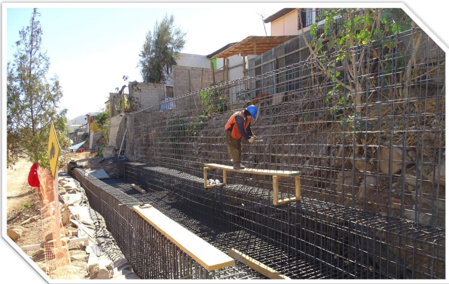
Muro de Contención Ferronor, Ovalle Inversión: $ 670 Millones
