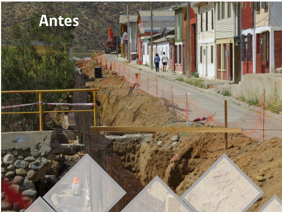
Muro de Contención, Alcalde Olivares. Canela
