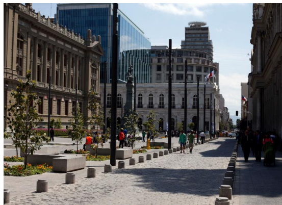
Ejemplo calle con calzada a nivel de acera
